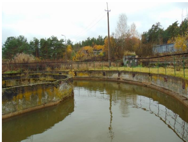
Рисунок. Отстойник сточных вод очистных сооружений г. Луга (фото авторов)
